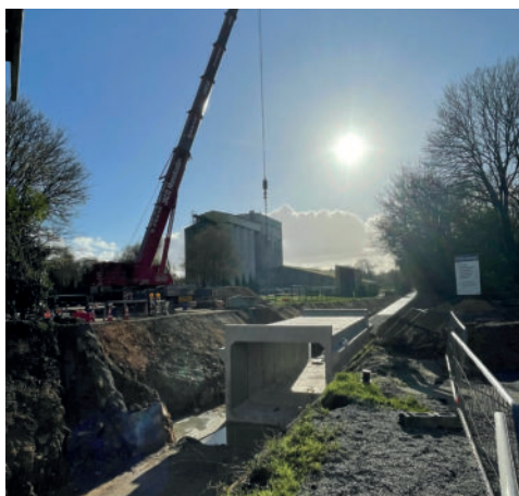
Voie verte : pose du pont cadre
